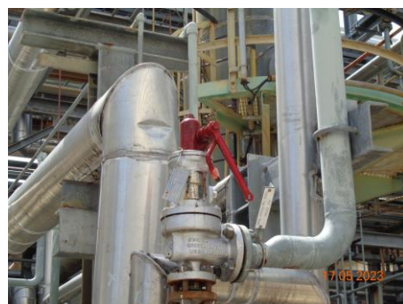
ภาพที่ 2.2-31 อุปกรณ์วาล์วระบายความดัน Pressure Relief Valve
