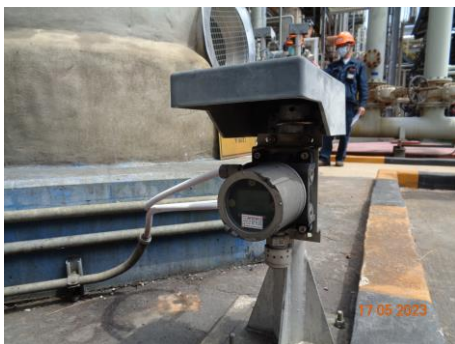
ภาพที่ 2.2-28 อุปกรณ์ตรวจจับก๊าซ Gas Detector
