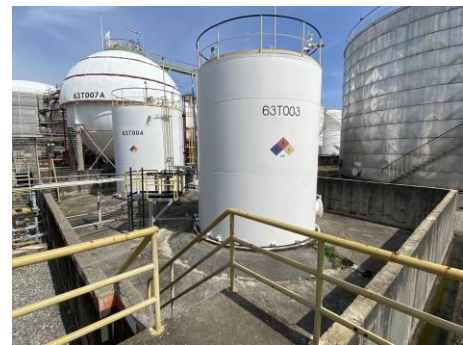
ภาพที่ 2.2-23 Bund Wall ป้องกันการหกรั่วไหลของสารเคมี
