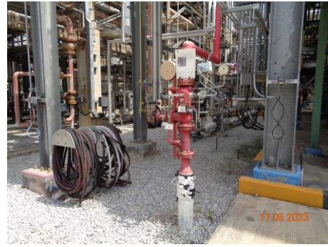
วาล์วน้ำดับเพลิงระบบเปิดแบบควบคุมด้วยมือ
