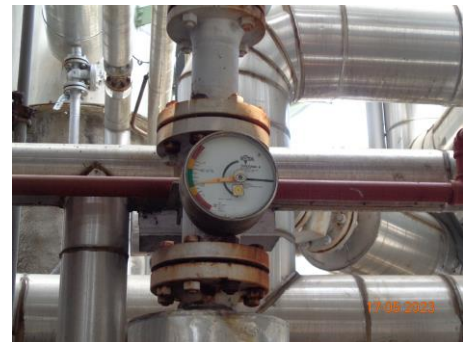
ภาพที่ 2.2-25 อุปกรณ์วัดอัตราการไหล Flow Rate
