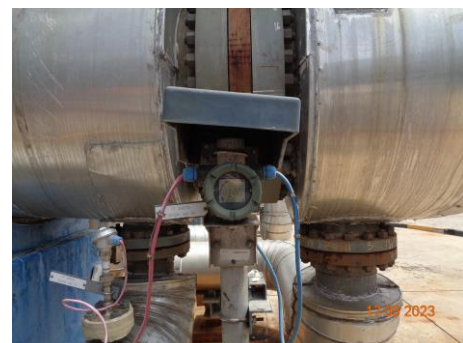
ภาพที่ 2.2-27 อุปกรณ์วัดอุณหภูมิ Temp Indicator
