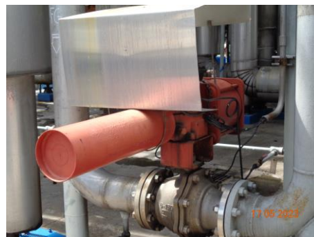
ภาพที่ 2.2-29 อุปกรณ์วาล์วตัดแยกระบบ Emergency Isolation Valve
