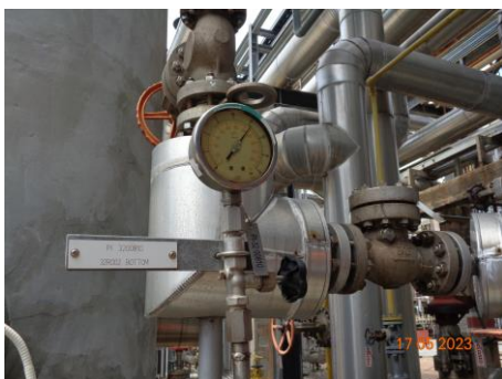
ภาพที่ 2.2-26 อุปกรณ์วัดความดัน Pressure Indicator
